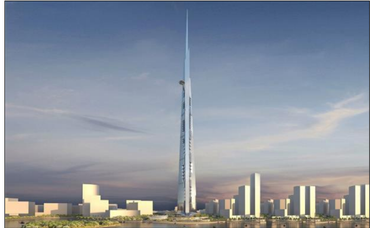
[Bildquelle: Lesemann, H., Heinzelmann, H., Jeddah Kingdom Tower – polymergestützte Herstellung von Großbohrpfählen in schwierigem Baugrund, Vortrag Geotechnik-Tag in München, 2014]
