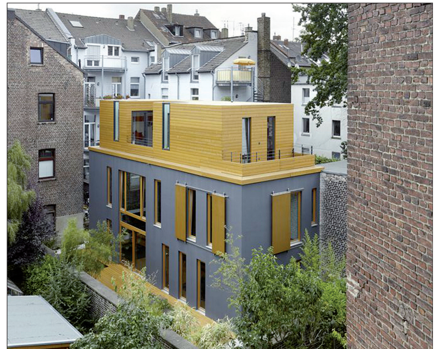
Das 15 m lange und 5 m breite Einfamilienhaus liegt im Hinterhof eines viergeschossigen Altbaus. Der graue Kubus wurde erst später mit einem Staffelgeschoss in Holzbauweise aufgestockt.
