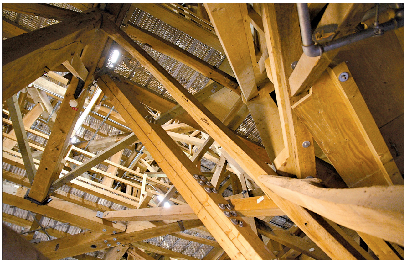
Das Oktogon ist mit über 1200 Jahren der älteste Teil des Aachener Doms. Der barocke Dachstuhl aus dem 17. Jahrhundert wurde seit 2001 mittels einer neu eingefügten Holzkonstruktion grundsaniert Fotos: St. Klein
